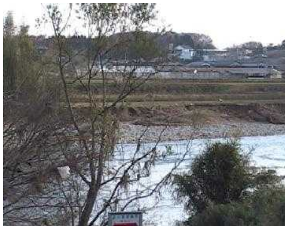
写真 4 加古川 36km 付近の河道被災状況
