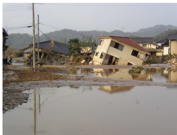
写真3 家屋の被災状況(神戸大学 川谷教授提供資料)
