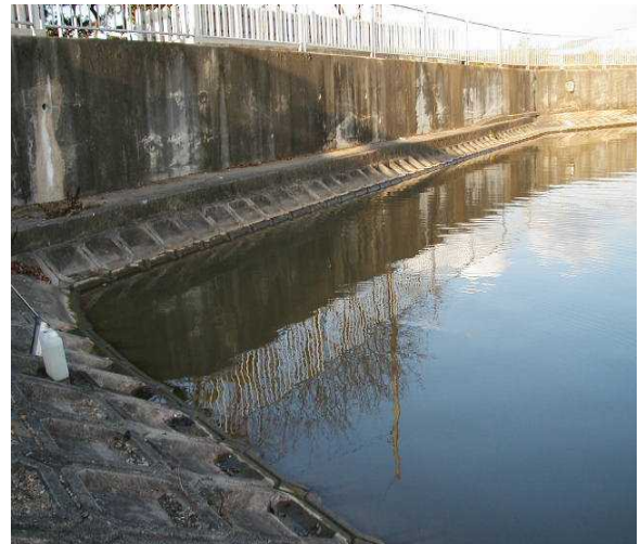
図3 印籠池の様子（コンクリート護岸）
