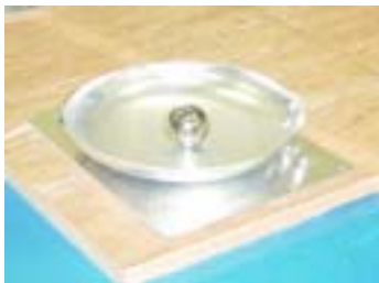
写真1 転がり支承部
