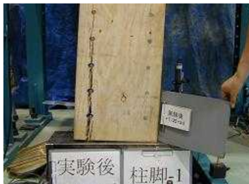
図 5 試験体の破壊状況
