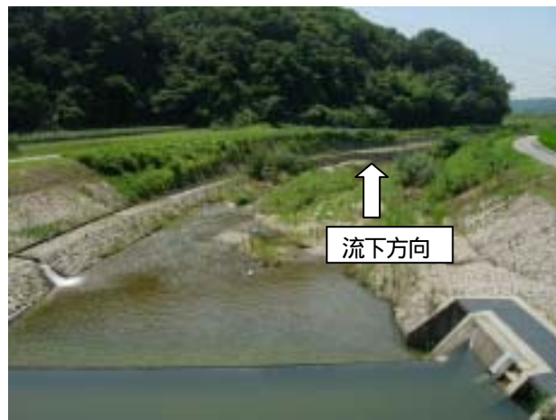
写真 2 St.2 西盛橋から下流方向の写真
