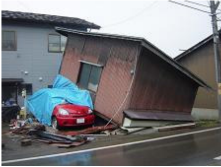
写真 1 木造住宅の倒壊状況 1)
