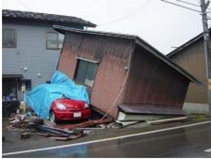
写真1 木造住宅の倒壊状況 2)
