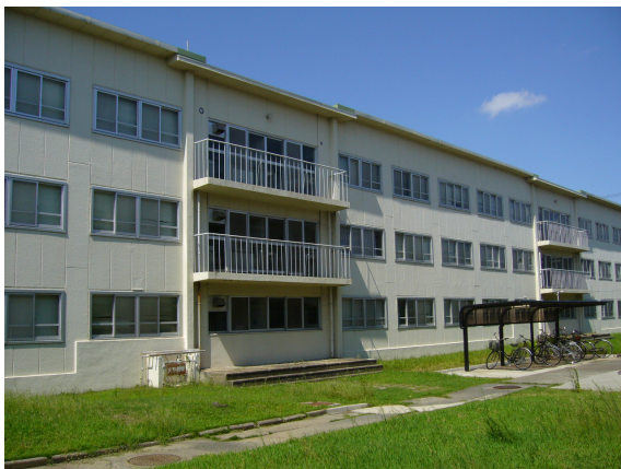
図5 A寮東南面の外観
