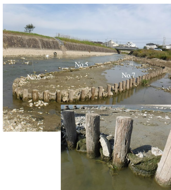
写真 4 木杭の設置状況(2020 年 10 月 28 日)
