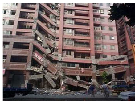
写真 1 RC 造建物の倒壊
