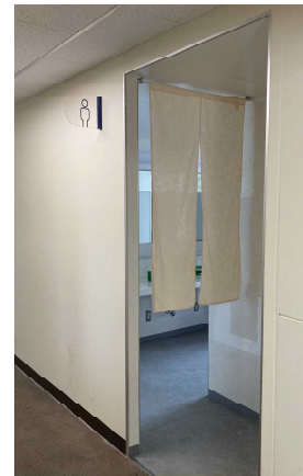
図3 改修後の男子トイレ入口
