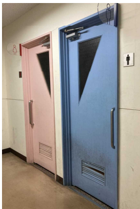
図1 改修前のトイレ入口
