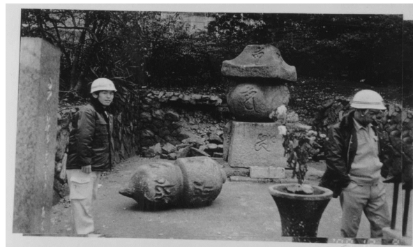
写真1 敦盛塚破壊後
