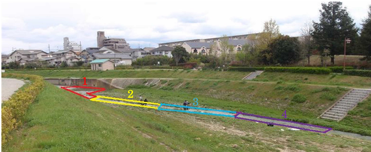
図7 堰下流側の調査地点
