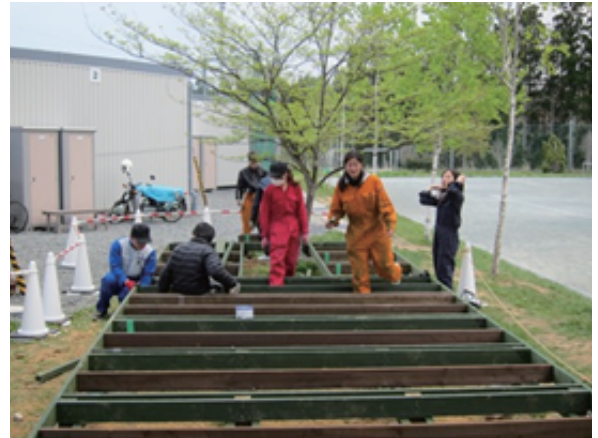
図7 根太の設置
