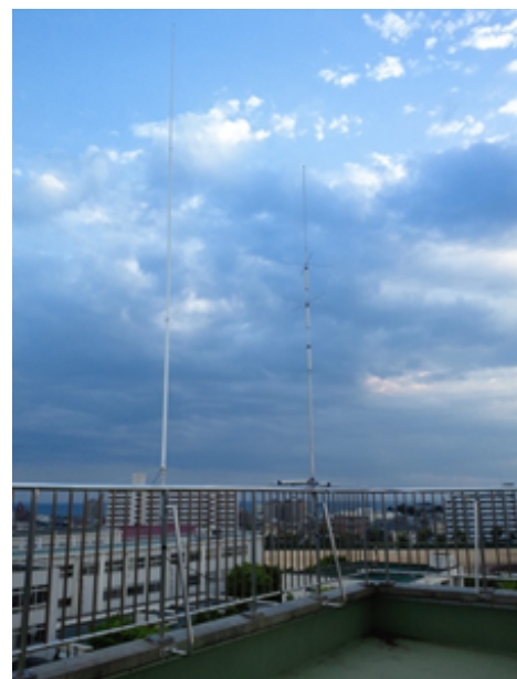
図2 設置したGPアンテナ
