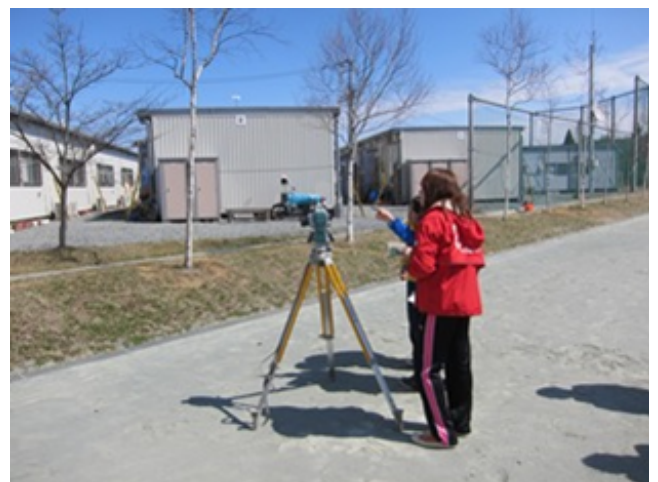
図 4 建設予定地の測量
